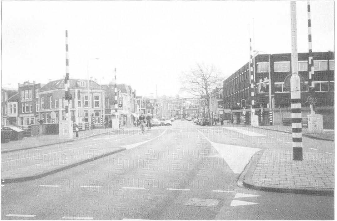
Foto nr. 6. De Eendrachtsbrug, vroeger de Basculebrug, met daarachter de Paterswoldseweg.
